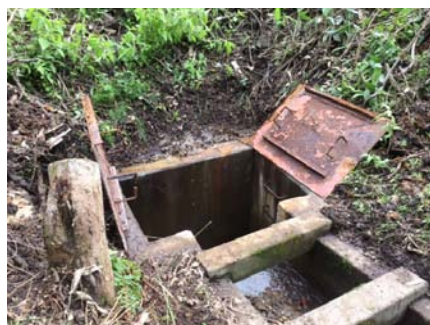
写真-3 パイプカルバート呑口の土砂詰まりの解消
