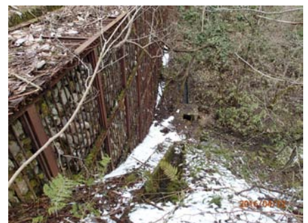
写真-4 鋼製大枠の現況
