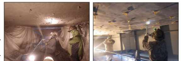
写真 3 下面増厚施工状況
