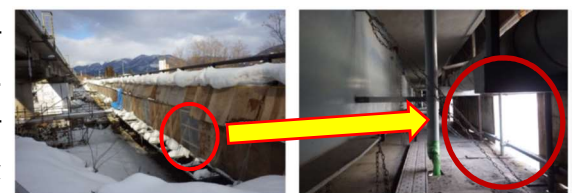
写真 4 明かり窓状況
