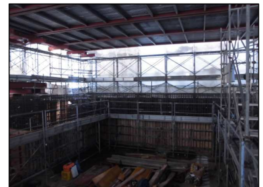
写真-3 養生屋根（屋内）状況
