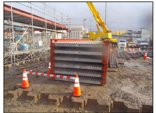
写真-1 フラットパネル状況
