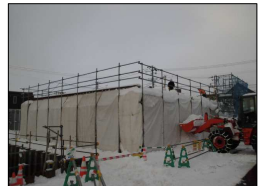
写真-2 養生屋根設置状況
