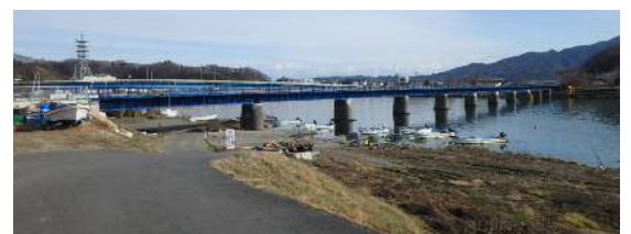
写真-3 復旧した第34 閉伊川橋りょう
