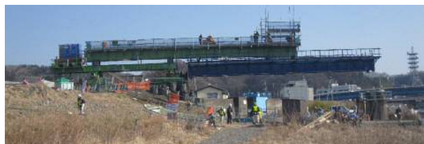
図-2 吊上げ台車による桁架設方法
