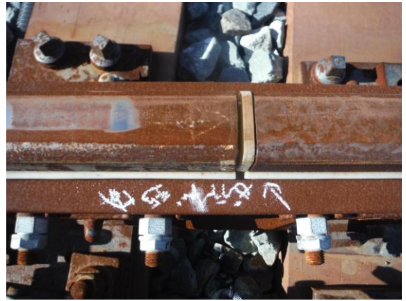
写真-1 遊間の開き、絶縁継目のずれ
