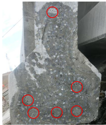
写真-2 主桁切断面
