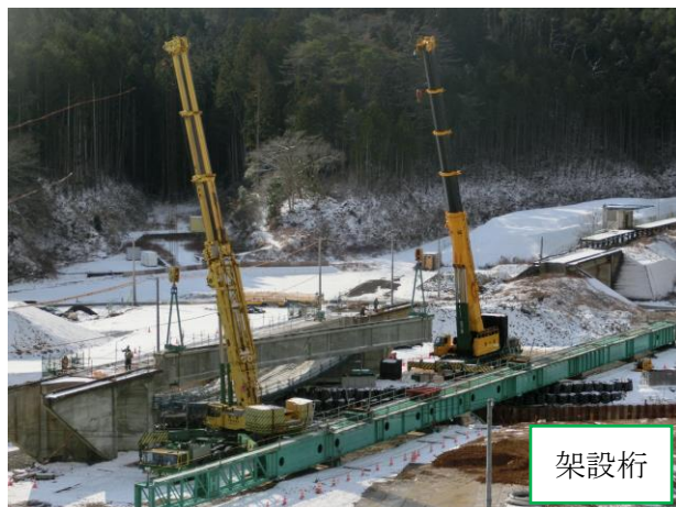
写真-1 クレーン相吊りによる主桁撤去
