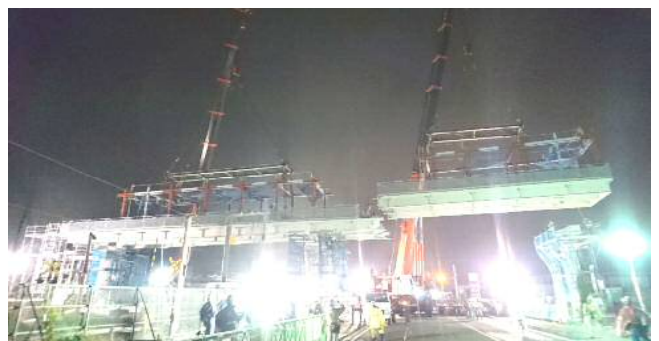
写真-1 架設状況（左：線路上空、右：道路上空）
