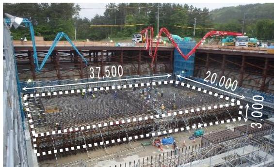
写真一1 コンクリート打設（底版）状況
