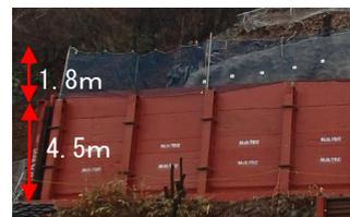
図-8 線路防護工 (H-300) 上部養生方法
