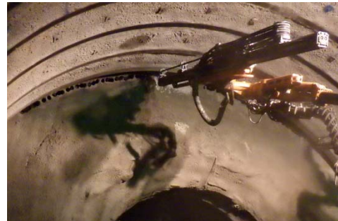
写真3 スリット溝 施工状況
