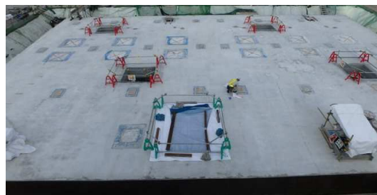
写真-4 コンクリート打設完了状況（底版）
