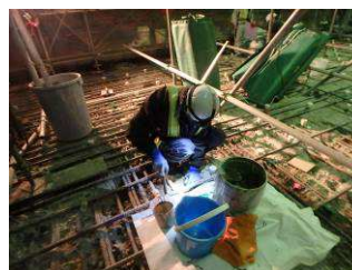
(a)作業遠景
