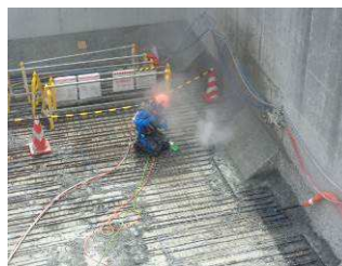
(a)作業遠景
