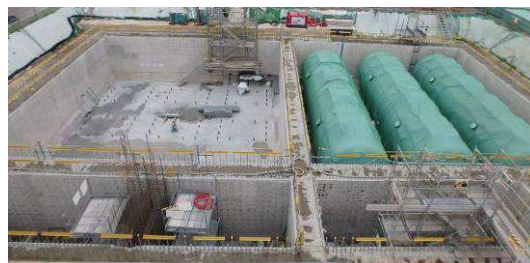
写真-3 ピット構築状況（側壁）
