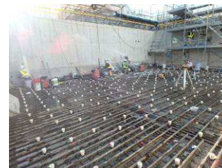
(b)設置完了
