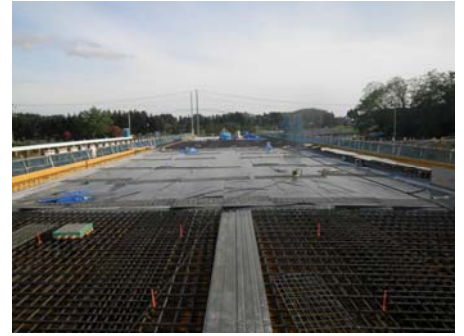
写真-3 養生状況
