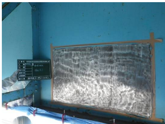
写真-1 既存塗膜試料採取状況
