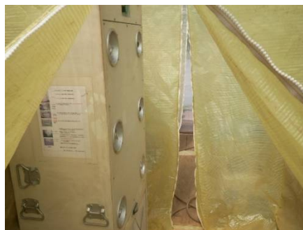
写真-3 洗身設備設置
