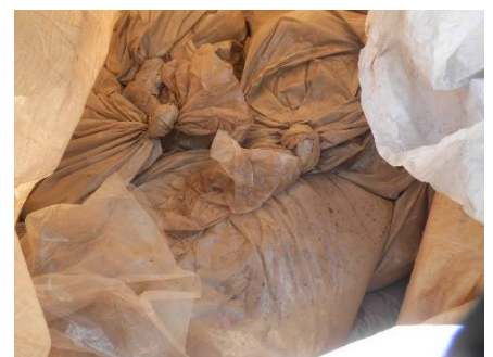
写真-4 塗膜屑等保管
