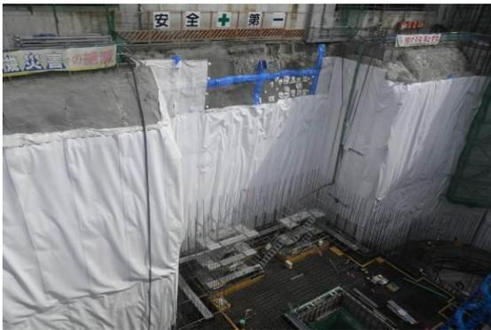
写真 - 2 防水シート施工状況
