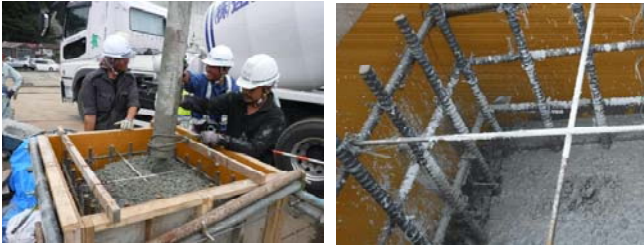
写真-1 吊し打ち(自由落下)、モルタル飛散・付着状況
