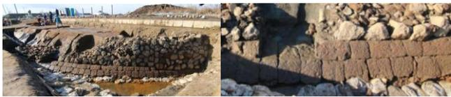
写真-1 御舟入堀・船溜り跡の2種類の石積み護岸
