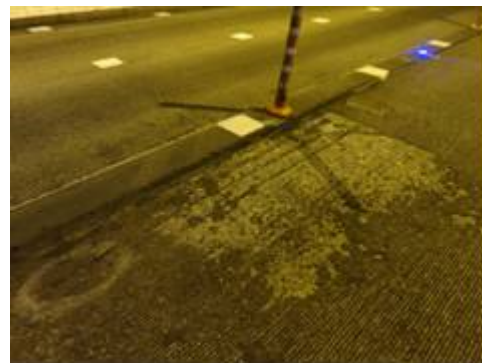
写真-1 路面隆起に伴う路面切削
