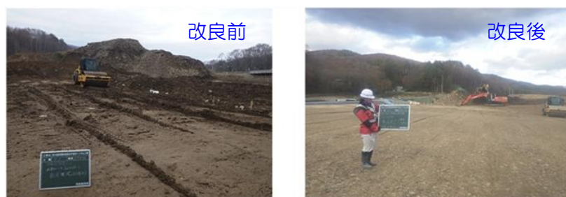
写真1 盛土モデルの施工状況
