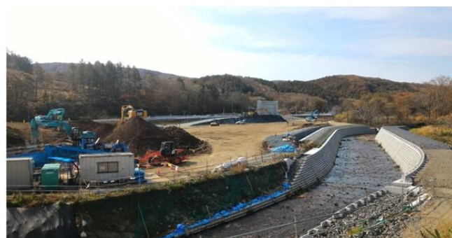
写真2 万能土質改良システム及び本線盛土全景
