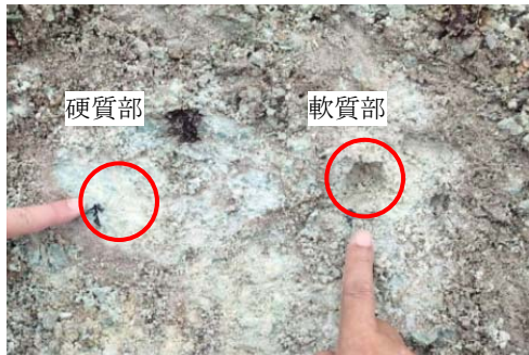
写真 3 のり面露頭の状況
