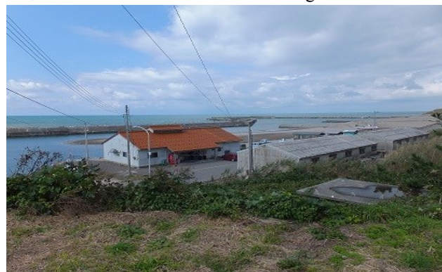
図-4 松ヶ崎漁港の港内堆砂状況写真(2016.10.15)
