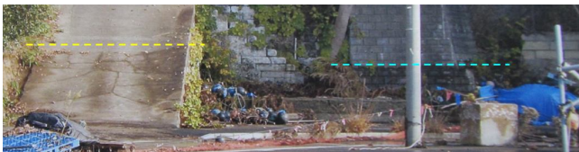
図3 東松島市大浜漁協での遡上高と浸水高 (写真提供：宮城県漁業協同組合宮戸支所)
