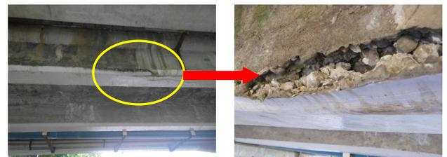
写真-1 G1 主桁の浮き
