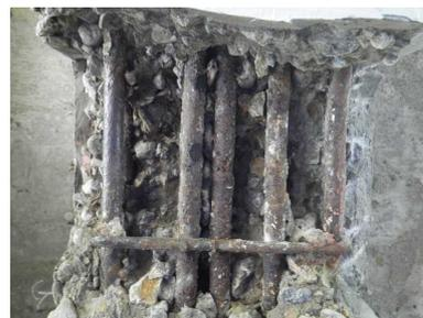
写真-2 G1 桁鉄筋径の減少
