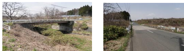
写真-1 全景写真
