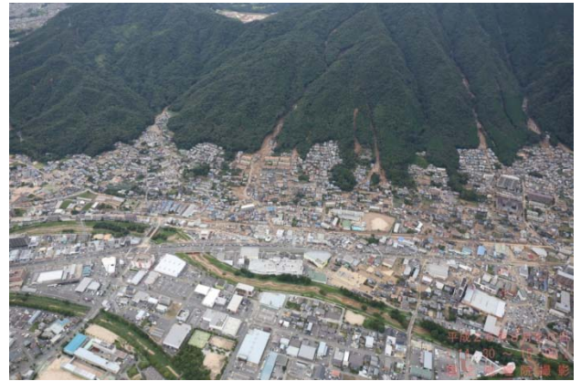
写真-1 2014/8/20 広島市土砂災害
