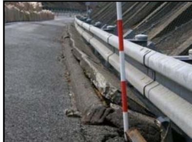
写真-3;路肩シールコンクリート損傷
