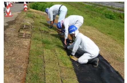
【写真-5】 ネットの上に芝を張る作業
