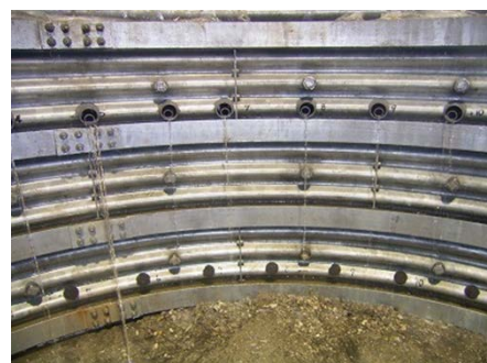
写真-3 地下水導水状況
