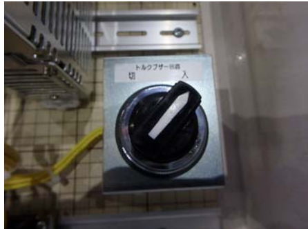
写真-5 トルクブザー回路
