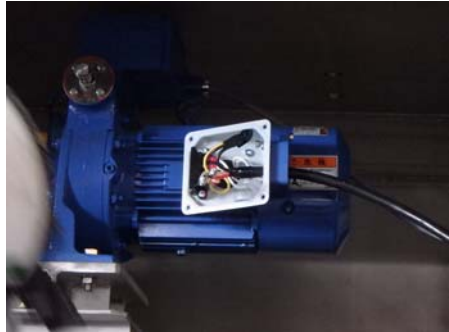
写真-6 TL への配線状況
