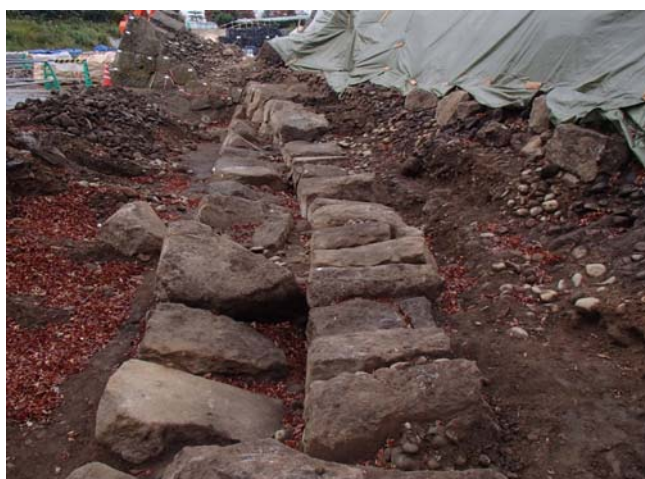
写真2 竹之丸2工区石垣の基底部の状況 (左側が古い石垣、右側が新しい石垣)
