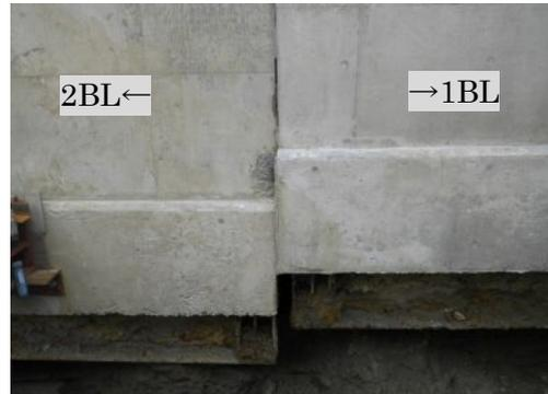
写真-1 洞道沈下状況 (洞道背面)
