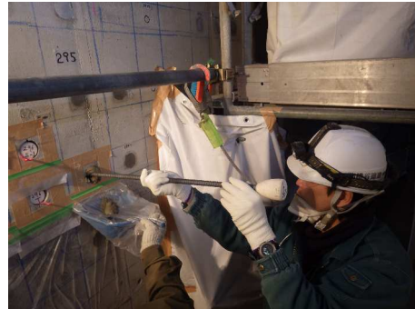
写真-2 CCb 挿入状況
