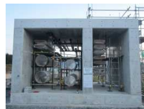
写真2 実物大モックアップ（壁厚は実物の1/2）
