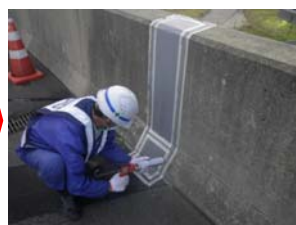
3. 養生テープ貼付後、シール施工
