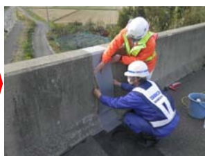
2. 防水シート貼付
