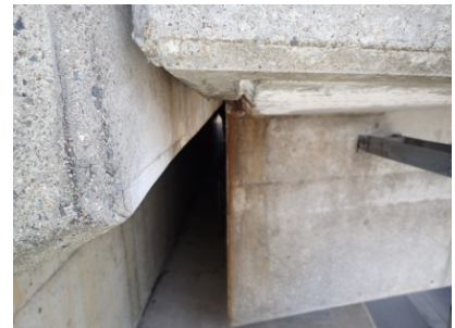
写真-7 散水後桁端状況(漏水なし)
