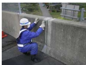
1. 施工箇所のケレン作業及び清掃
