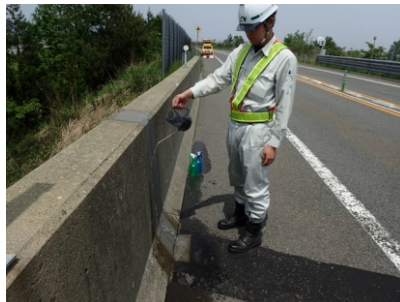
写真-6 壁高欄部漏水試験状況
