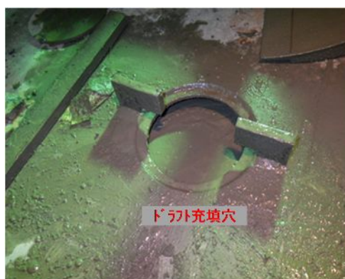
写真-2 高流動コンクリート(充填穴)
