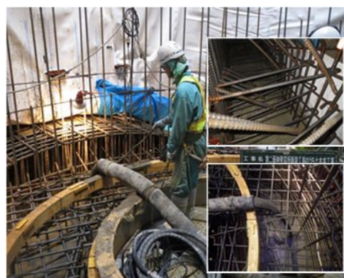
写真-1 高流動コンクリート(施工状況)
