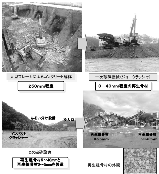
図-1 コンクリート解体、破砕、分級状況
