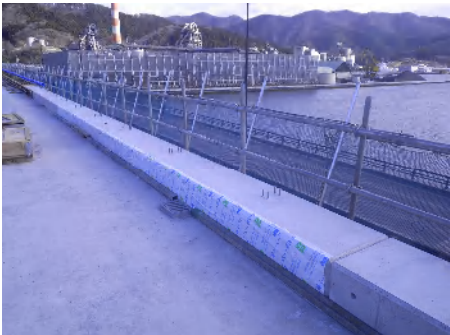
写真-1 保水養生テープ
