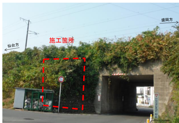
写真-1 現況写真（発進側より）
