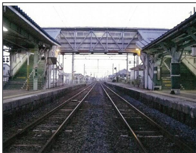
写真-1 湯沢駅構内乗換こ線橋
