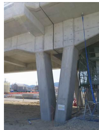
図－7 打設後の斜め柱
