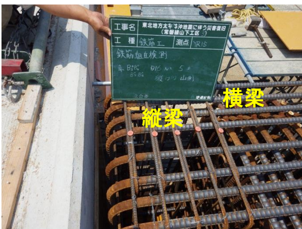
図－6 斜め柱の梁柱の接合部
