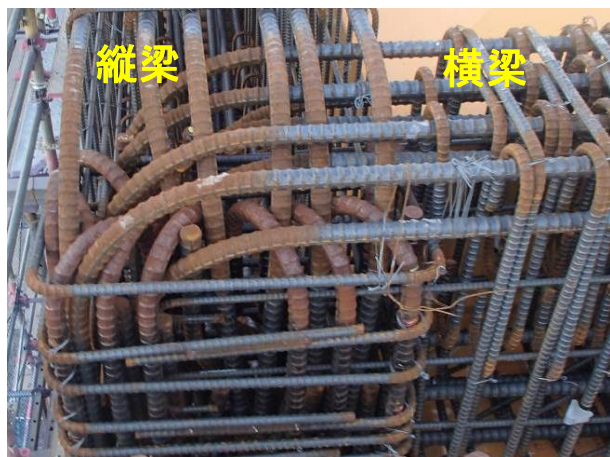
図-1 一般的な梁・柱接合部の配筋
