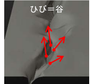
図-1 ひび割れの特徴
