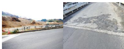
写真-2 A 橋(左)・B 橋(右)の橋面
