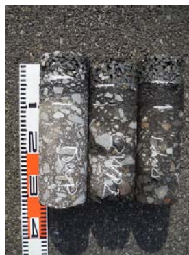
写真3 湿潤状態の基層
