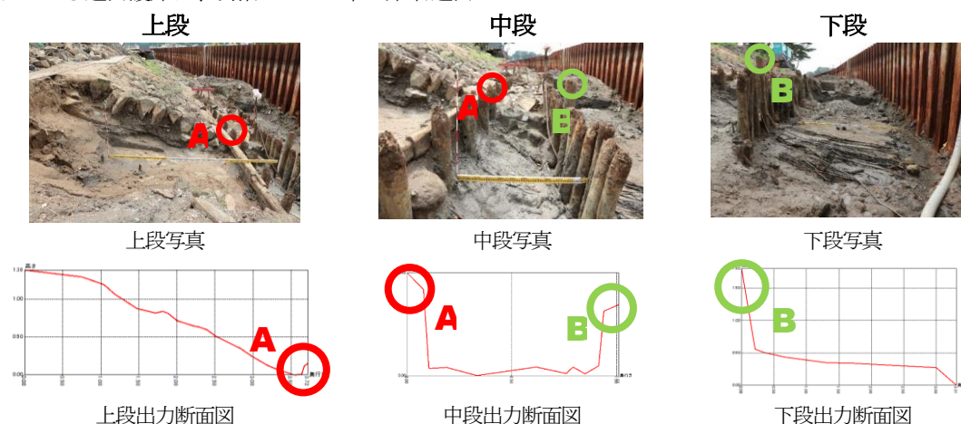
図-1 Photog-CAD による東名運河の柴工護岸調査 下段の柴工は、現在の計画河床高より約 1.3m 下方に柴工が施工された。この発掘場所から亀岡橋方向約 150m 南の地点でも柴工護岸が発見された。しかし、2 列の杭木群の運河側には柴工は確認されていない。この地点では、2001 年に機械で切断された稲井石（20×20×50cm 程度）と吸出し防止シートを用いた護岸が施工されたが、旧稲井石護岸との境界水位は平均水面 +0.22m より上方である。これは平均水面から朔望平均満潮面の水位では船舶の航跡波などで護岸が崩れていたことを示す。
