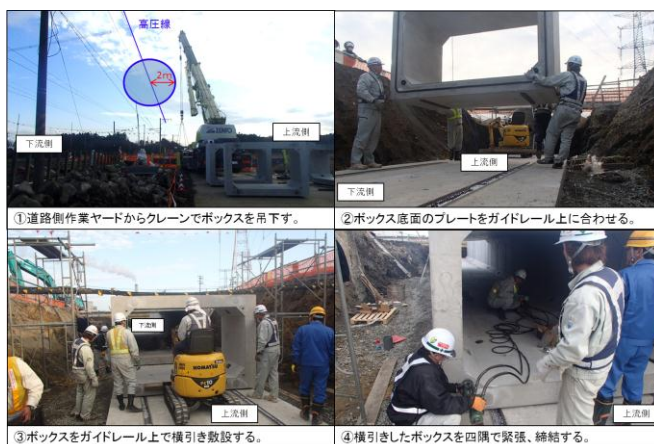
図－6. 横引き工法施工状況
