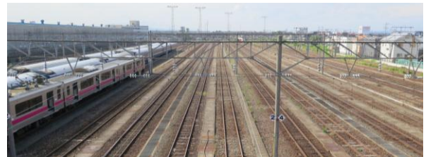
写真—1 当該車両センターの現状
