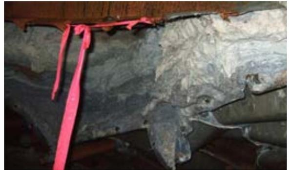
写真-1 集水井破断状況
