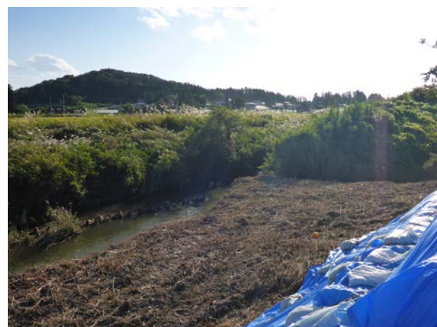
図5 芋埤川の破堤現場から見た堤外地
