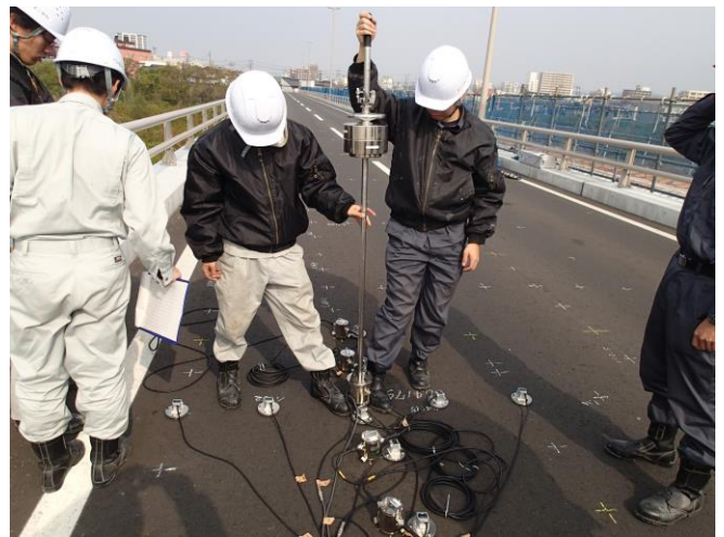
写真-2 小型 FWD 試験実施状況
