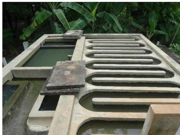
図2 水平迂流式のブロック形成池
