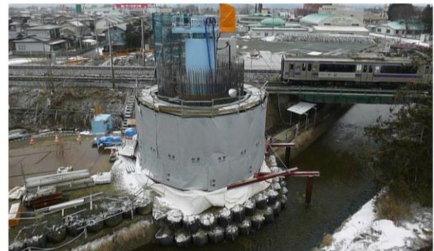
写真-1 ケーソン基礎施工状況 (全景)
